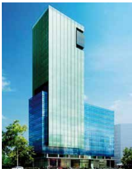
Torre Green Towers, Barranquilla (Colombia). Arquitecto: Gómez Piedrahita Arquitectos. Fachadista: Aluman.
