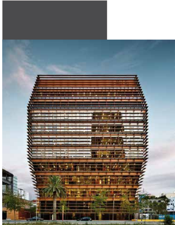
CMT, Barcelona. Arquitecto: Batller i Roig Arquitectos. Fachadista: Moyser.
