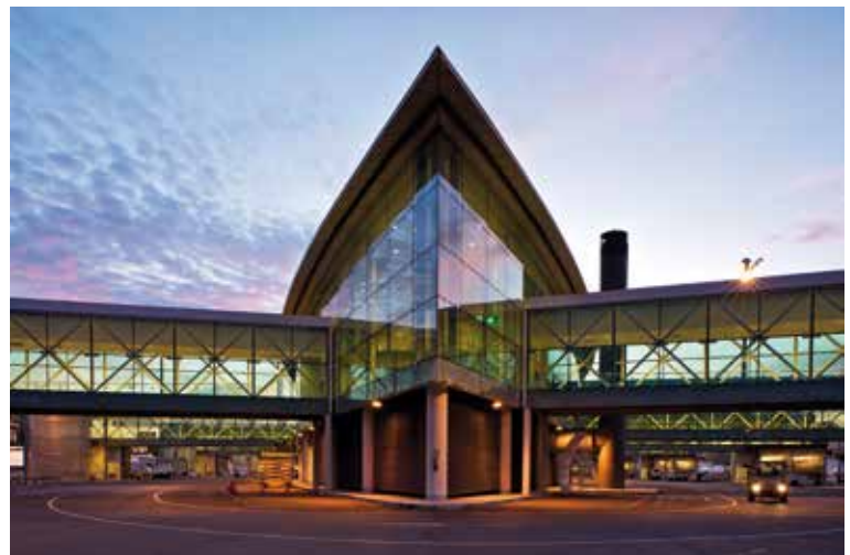
Terminal T1, Aeropuerto de El Prat, Barcelona. Arquitecto: Ricardo Bofill. Fachadista: Calvià - Espalu.
