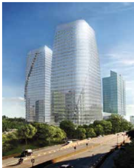
Torre Vió, en São Paulo, Brasil. Arquitecto: César Pelli. Fachadista: Grupo Galtier.
