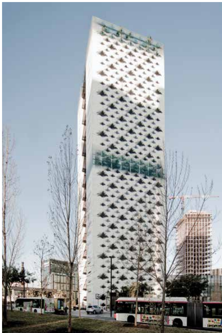
Hotel Catalonia, L'Hospitalet de Llobregat, Barcelona. Arquitectos: Jean Nouvel y Ribas i Ribas Arquitectes. Fachadista: Proyec.
