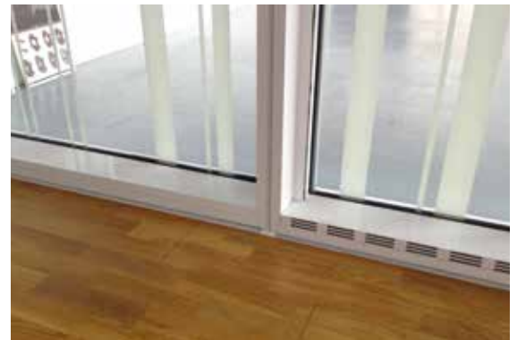
Detalle travesaño con y sin ventilación
