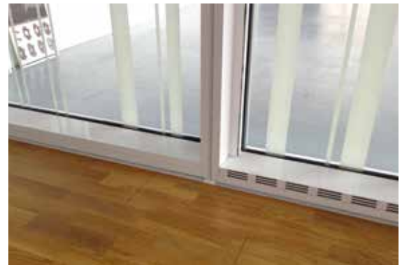
Detalle travesaño con y sin ventilación
